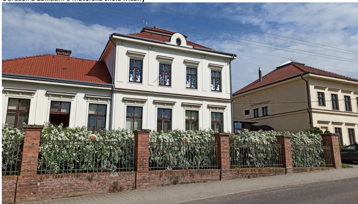
Obrázek 2 Základní a mateřská škola Mžany
